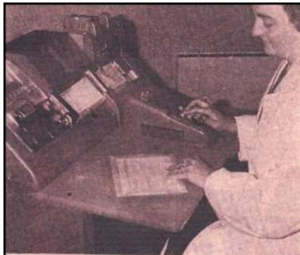
Um den Tabelliermaschinen und dem Elektronenrechner die richtigen Impulse geben zu können, müssen die Lochkarten, die im Rechenzentrum schwarz erstellt werden, nochmals geprüft werden. So kann eine Fehlarbeitung und eine falsche Auswertung vermieden werden. Unser Bild zeigt eine der Angestellten beim Prüfen einer Lochkarte.
