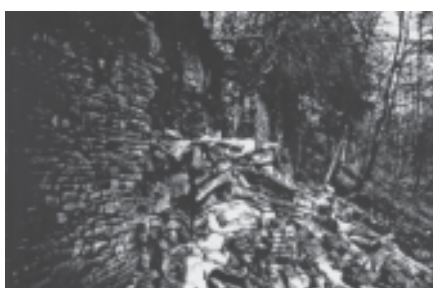
Der Teilversturz der Terrassenmauer. Foto: Nicola Kutz, 1988.
