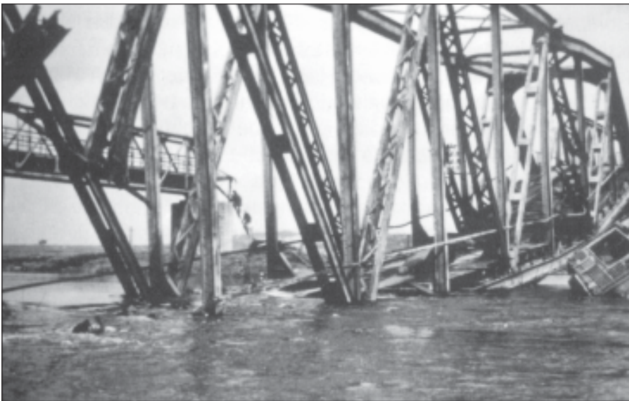
Die zerstörte Eisenbahnbrücke der Strecke Schwerte – Iserlohn über die Ruhr
