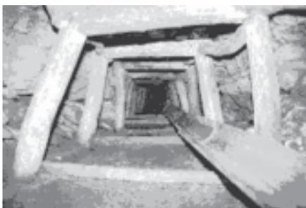
Abb. 8: Ausgebauter Verbindungsberg mit Rutsche
