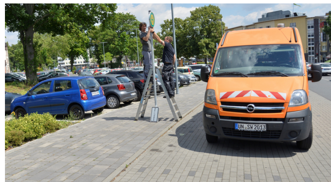
Mitarbeiter des Baubetriebshofes bringen das Haltestellen-Schild an. Foto: Stadt Schwerte
