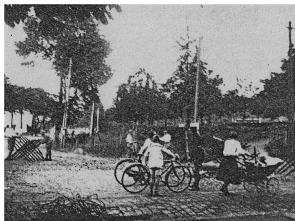
Beseitigung der Befestigungswerke an der Kontrollstelle Gockel
