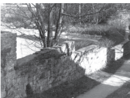
Blick in den unteren Südwall mit der Stützmauer zur Pastorats- wiese, um 1990. Foto R. Stirnberg, um 1990.
