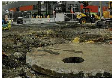
Abdeckplatte des Brunnenschacht (2016).
