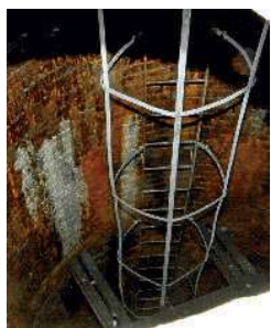
Brunnenschacht mit der Steigleiter (2016).
